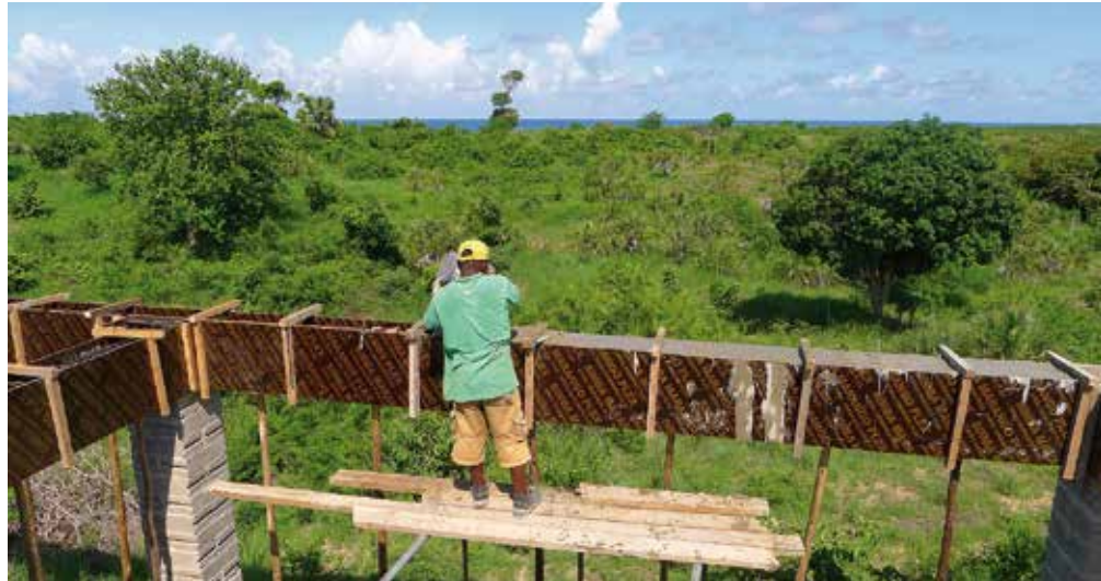
NOTWENDIGE ERWEITERUNG DES RINGANKERS - AUSBLICK VOM DACHGESCHOSS
