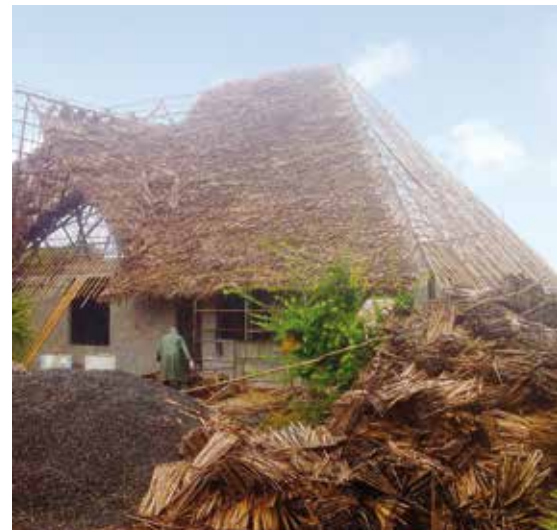
DAS MAKUTI DACH WIRD GEDECKT
